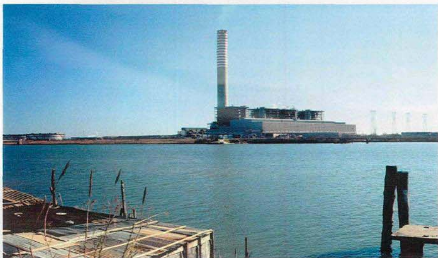
LA CENTRALE ENEL DI PORTO TOLLE. IN ALTO: FULVIO CONTI E, A DESTRA, ROSA FILIPPINI
