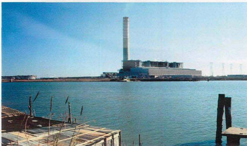
LA CENTRALE ENEL DI PORTO TOLLE. IN ALTO: FULVIO CONTI E, A DESTRA, ROSA FILIPPINI
