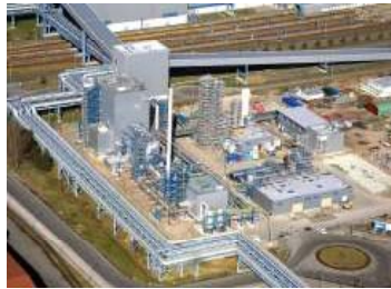
Vattenfall Schwarze Pumpe Germany - 30 MWth Oxy - Lignite
