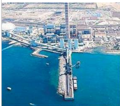
La centrale Enel di Torrevaldaliga (Civitavecchia) e Andrea Clavarino, presidente di Assocarboni
