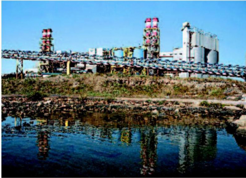
Allo scoperto. L'attuale carbonile della centrale termoelettrica di Brindisi Nord
